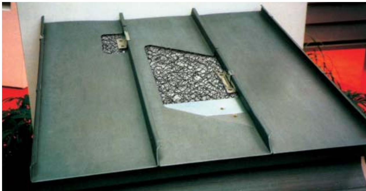
Kis lejtésű PLX lemezfedés szellőzőszőnyeg elválasztó réteggel
