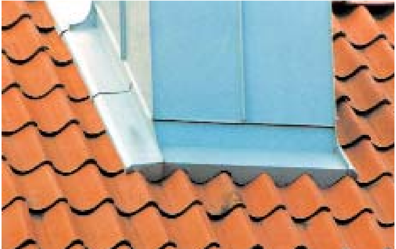
Kémény szegélyezése hullámcserepnél
