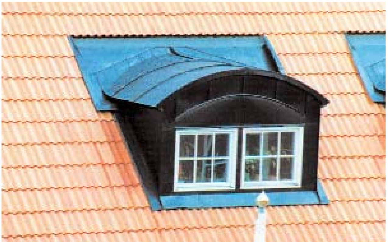
Tetőablak szegélyezése cserépfedésnél
