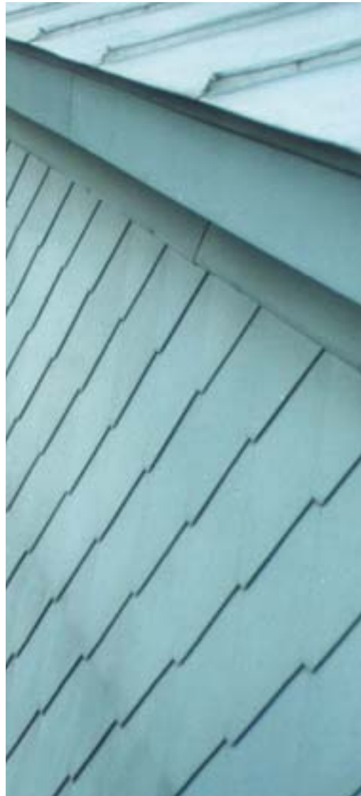
Korcolt tető és pikkelyfedés csatlakozása
